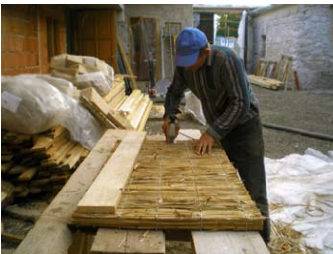
Zuschnitt von Schilfdämmplatten.
