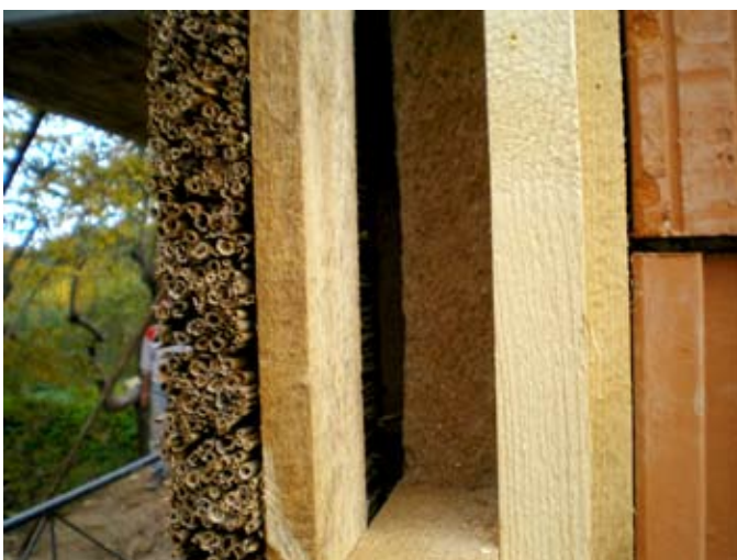
Wandaufbau im Schnitt.
